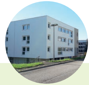
Bar-le-Duc : rue de Lorraine / allée de Bourgogne 5 bâtiments ● 67 logements Montant des travaux : 3,8 M€.
